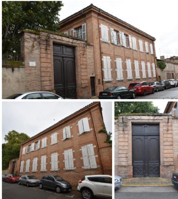
Photo 4 : Vues de l'extérieur de l'immeuble / Ministère de la Culture, Médiathèque du patrimoine et de la photographie
